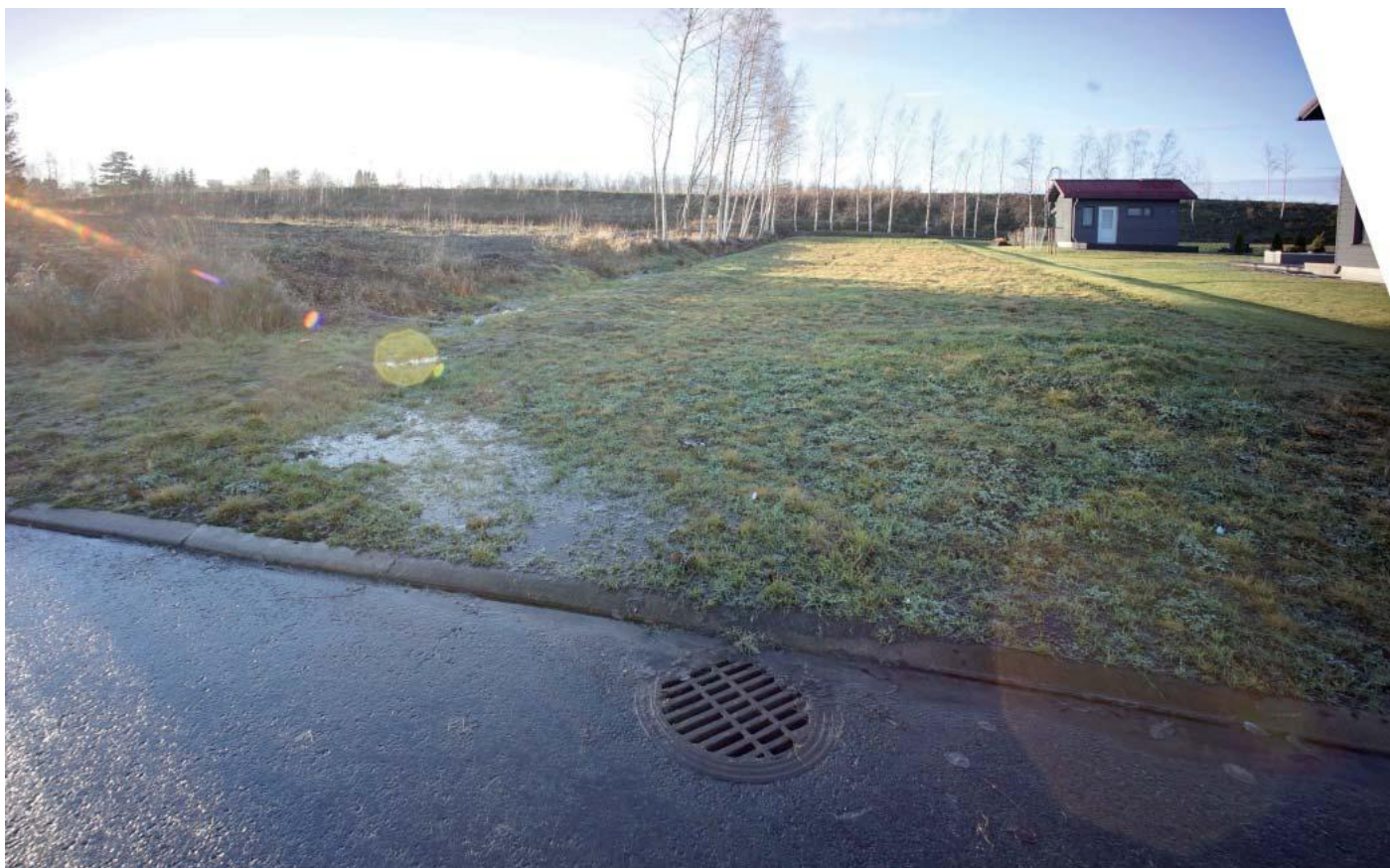
Jussilankujan alin sadevesikaivo korttelin 527 tontin 3 etelärajan tuntumassa.
